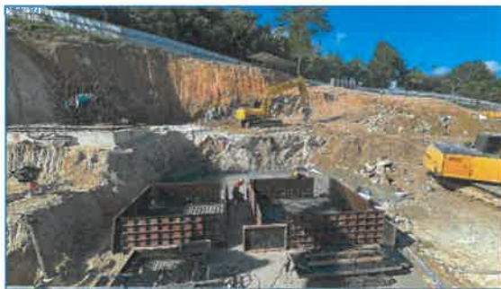
ภาพถ่ายที่ 2.1-1 การขุดแบบลาดเอียงและการใช้ฐานรากชนิดฐานแผ่
