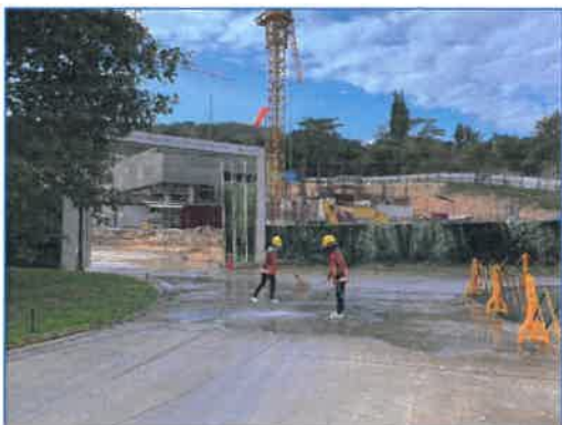
ภาพถ่ายที่ 2.1-5 จุดล้างล้อรถก่อนออกจากโครงการ การฉีดพรมน้ำ และล้างทำความสะอาดบริเวณทางเข้า-ออกโครงการ
