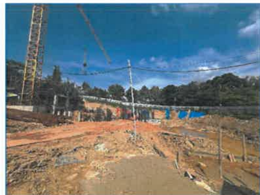
ภาพถ่ายที่ 2.1-1 การขุดแบบลาดเอียงและการใช้ฐานรากชนิดฐานแผ่
